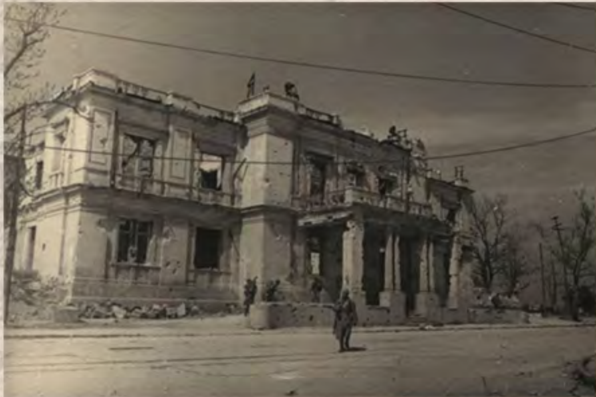
В освобожденном Севастополе. Разрушенный немцами Дом Флота. 11 мая 1944 г.
