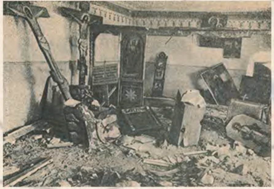
Внутренний вид Успенского собора Святогорского монастыря, взорванного и разрушенного немцами
