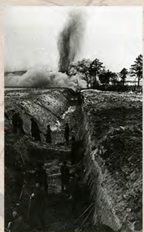
Строительство оборонительных укреплений на подступах к Москве. Осень 1941 г.
